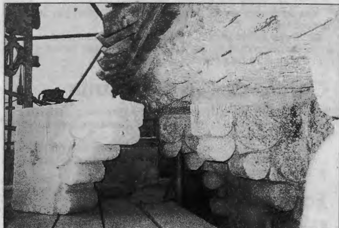
Les modillons à copeaux, le neuf et les existants se font face rageusement
