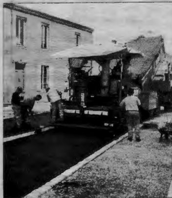
L'entreprise Lefebvre a déposé la couche d'asphalte sur la rue de Verdun.
