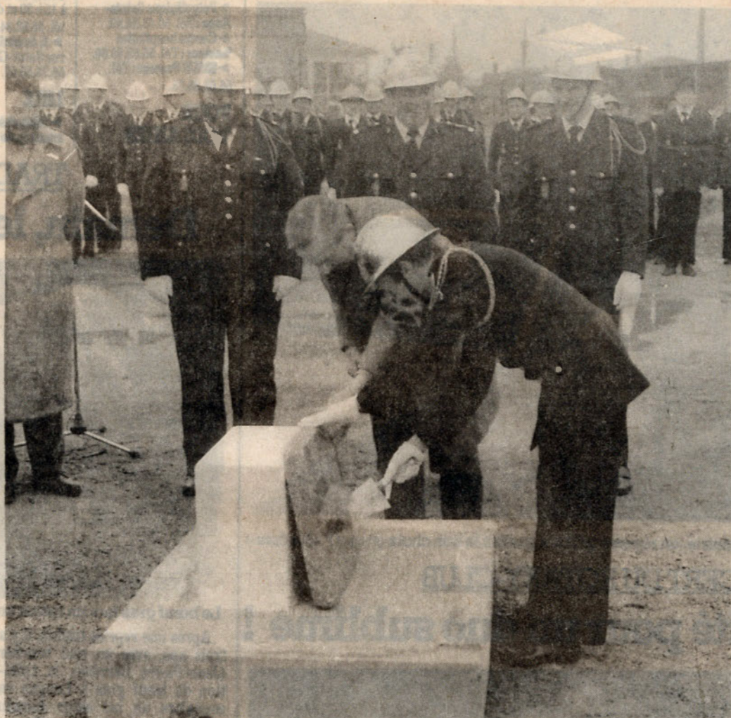
Pose de la première pierre par M. Lafourcade
