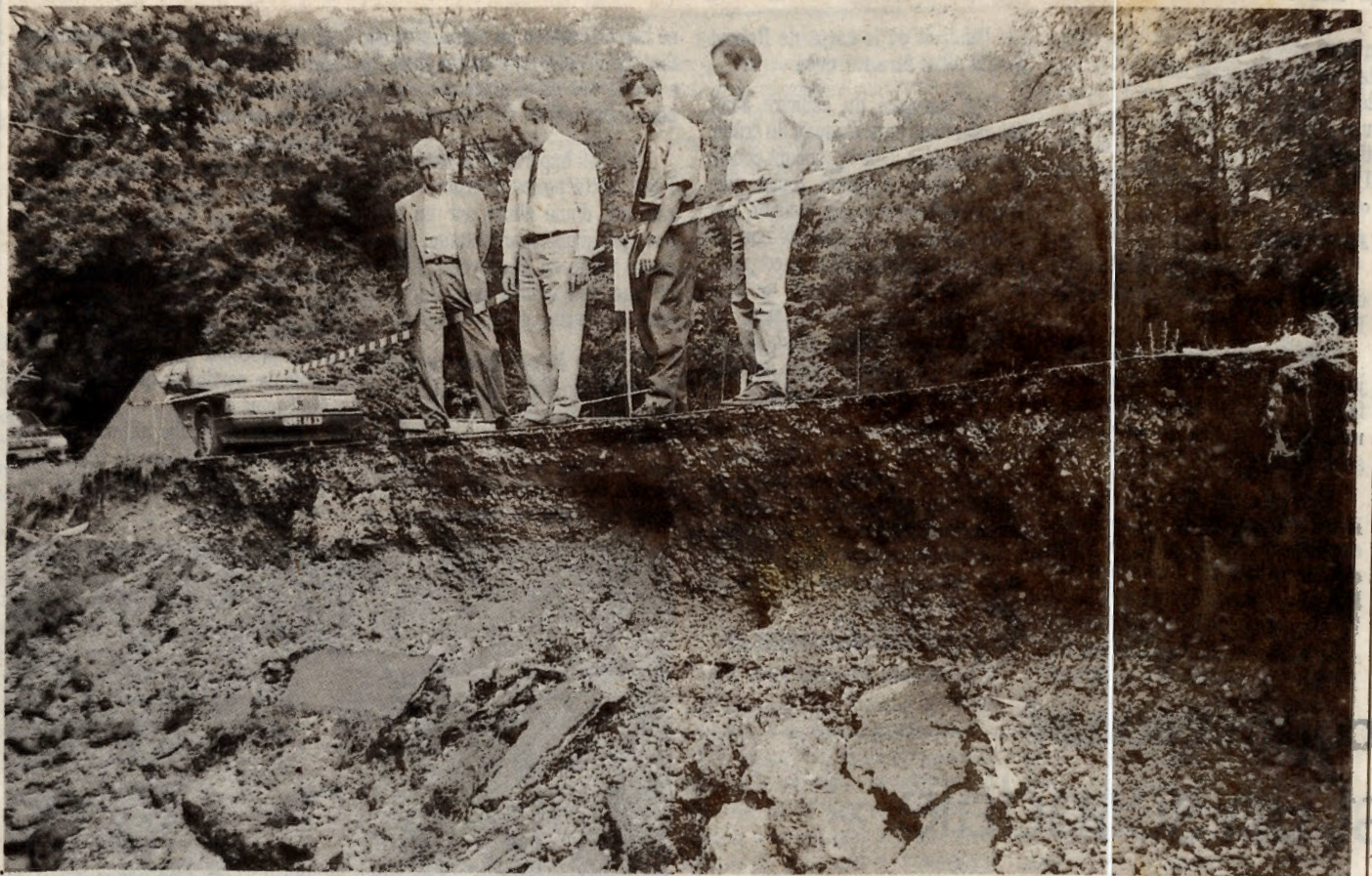
En plusieurs endroits, les chaussées se sont effondrées. MM. Trupin, Langrand et Lacoste, accompagnés du maire de Langon, ont fait l'état des lieux (Photos Hervé Pons, « Sud-Ouest »)
