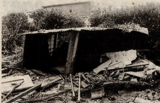
Ce qu'il reste d'un garage après le passage du torrent de boue à Saint-Pierre-d'Aurillac
