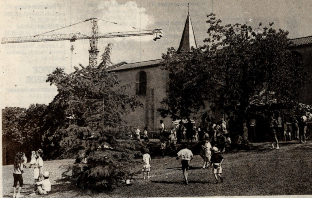
La kermesse au pied de la chapelle et du chantier de la maison de retraite
