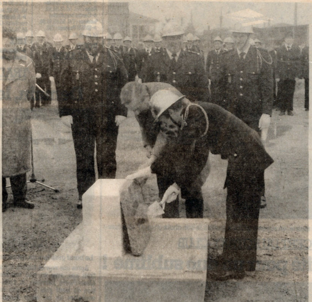
Pose de la première pierre par M. Lafourcade
