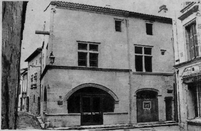
La Maison de pays et son extension récemment libérée des échafaudages
