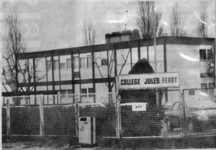
Le collège Jules-Ferry, dont le sort est étroitement lié apparemment à celui du coll (Photos H.P., « Sud-Ouest »)
