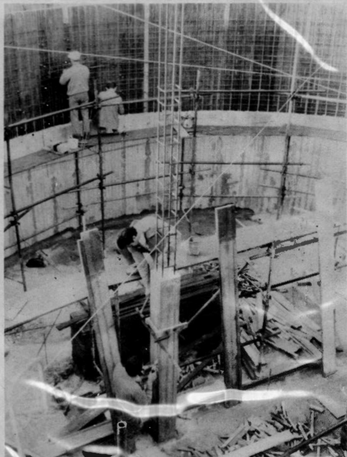
L'intérieur de la bache de stockage de Verdélais en cours de coffrage (Photo S. Sanche, «Sud-Ouest»)
