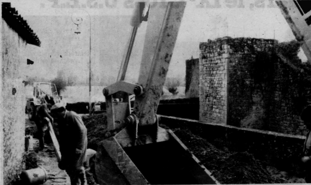
Devant la porte du Thuron sont posées deux canalisations P.V.C., l'une de diamètre 200 pour l'assainissement, l'autre de diamètre 140 pour l'eau potable
