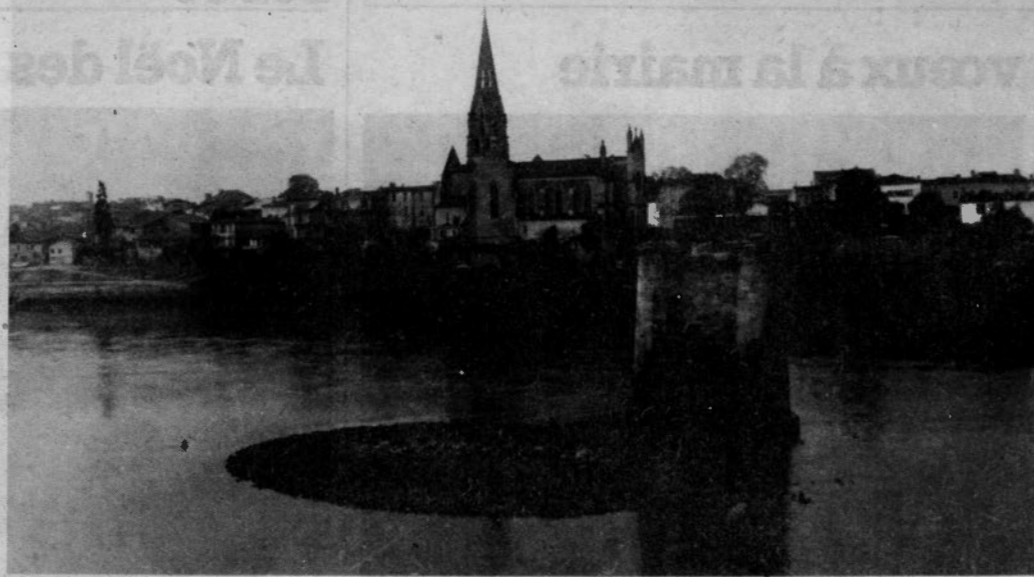
Sur les piles du vieux pont, une passerelle pour deux roues et piétons (Photo A. Derost)
