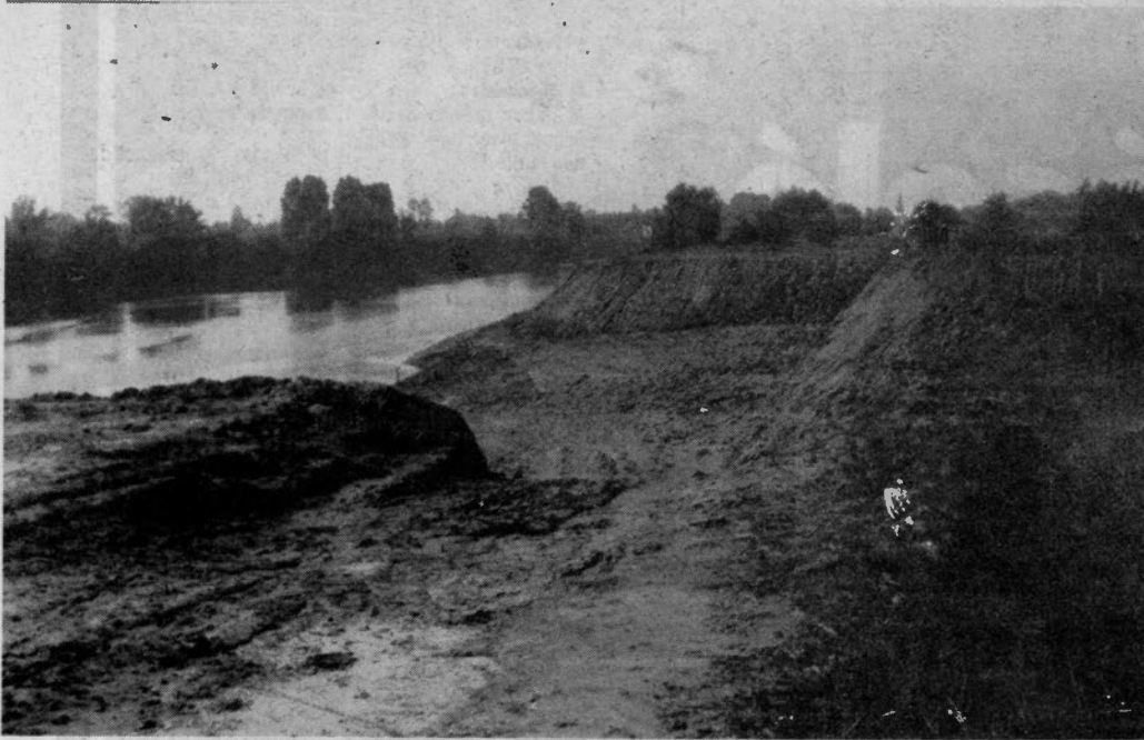
L'emprise du futur pertuis côté aval avec, à droite, l'île (Cliché « Sud-Ouest »)
