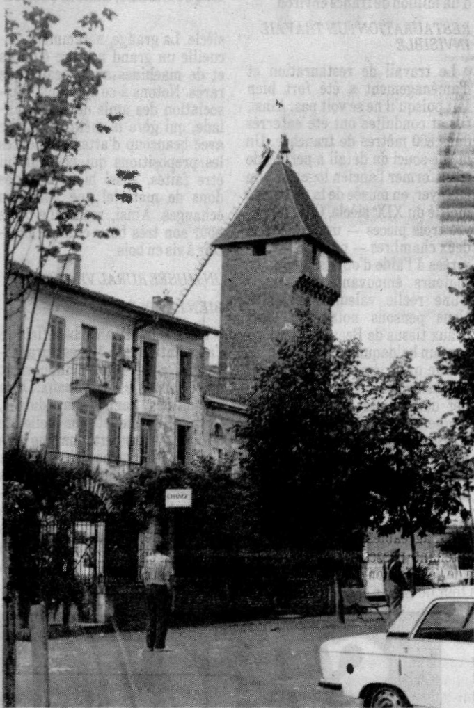
Une réparation spectaculaire (Photo « Sud-Ouest »)
